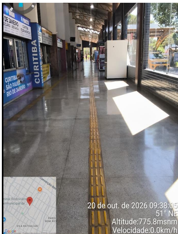
Pista tátil e piso limpo na vistoria
