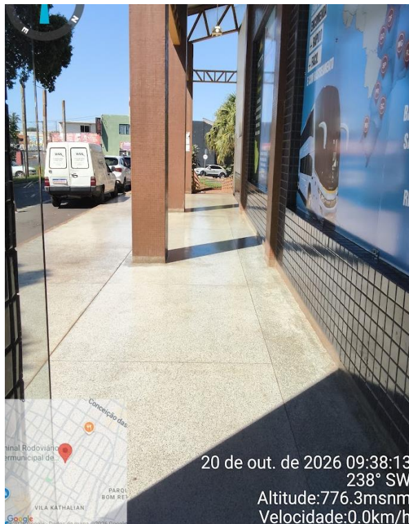
Piso externo do saguão de acesso, limpo
