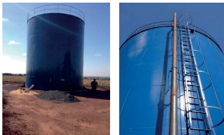
Figura 34: Reservatório R3 – Jd. Beluzzo.
