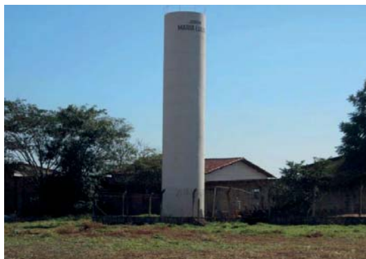
Figura 44: Reservatório R10 – Almoxarifado.
