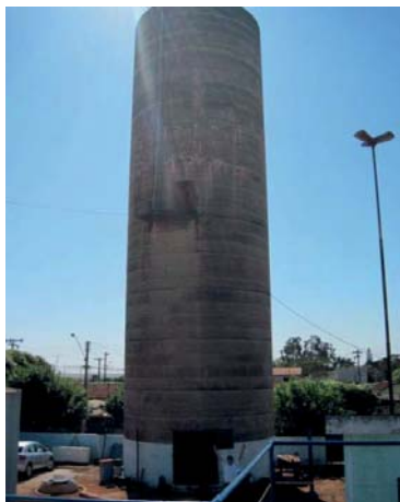
Figura 20: Reservatório R2 – ETA.
