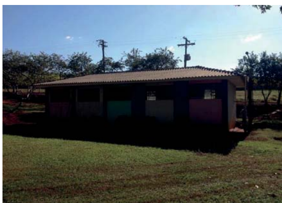
Figura 8: Casa de bombas – Unidade de captação superficial Córrego do Sucuri.
