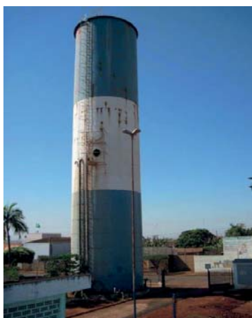
Figura 19: Reservatório R1 – ETA.
