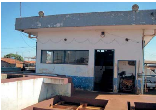
Figura 16: Casa do Operador – ETA.
