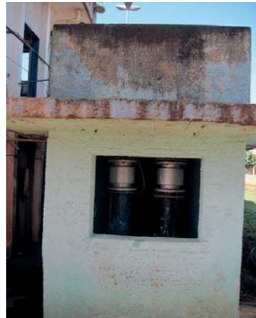
Figura 13: Chegada das adutoras de água bruta na ETA.
