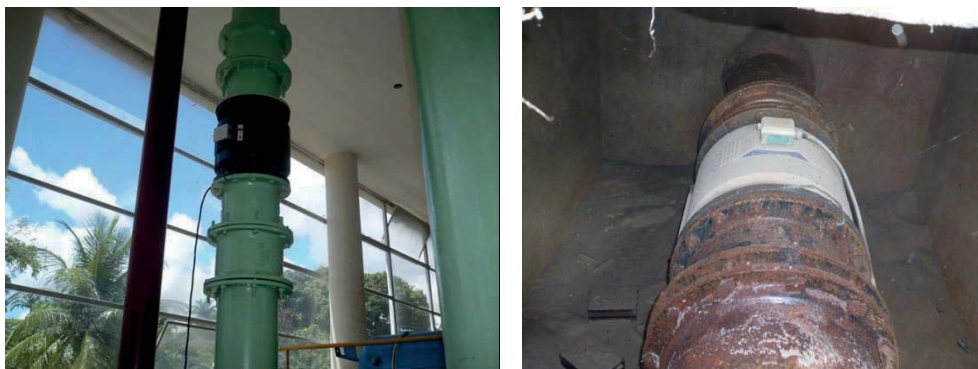
Figura 119: Medidor Eletromagnético tipo carretel.
