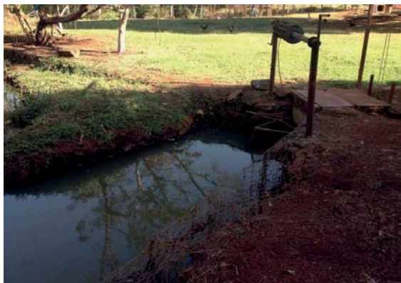
Figura 7: Captação superficial Córrego do Sucuri.
