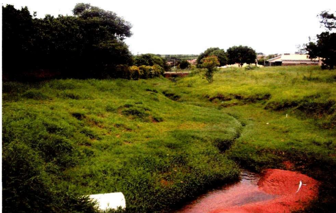
Foto. 02 – Detalha o Córrego Cisterna a jusante e mostra ao fundo a ponte de concreto da Rua Lauro Sodré.
