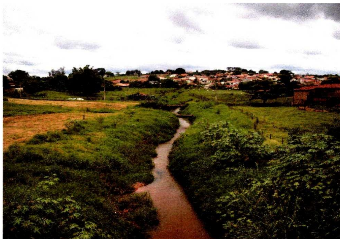
Foto.5 – Vista da ponte da Rua Pedro de Toledo, mostrando a tubulação de condução de esgoto e ao fundo a ponte de madeira da Rua João Bolsone.
