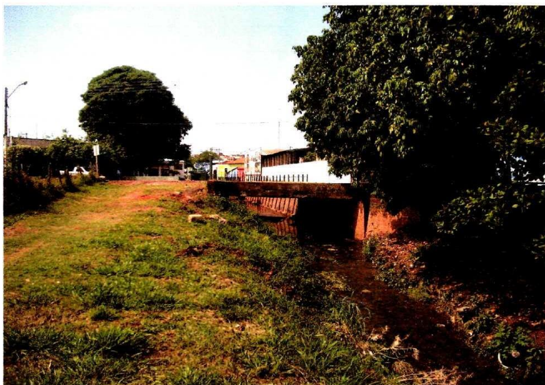
Foto. 4 – Mostra a ponte da Rua Cincinato Braga, final da porção canalizada do Córrego Monjolinho.
