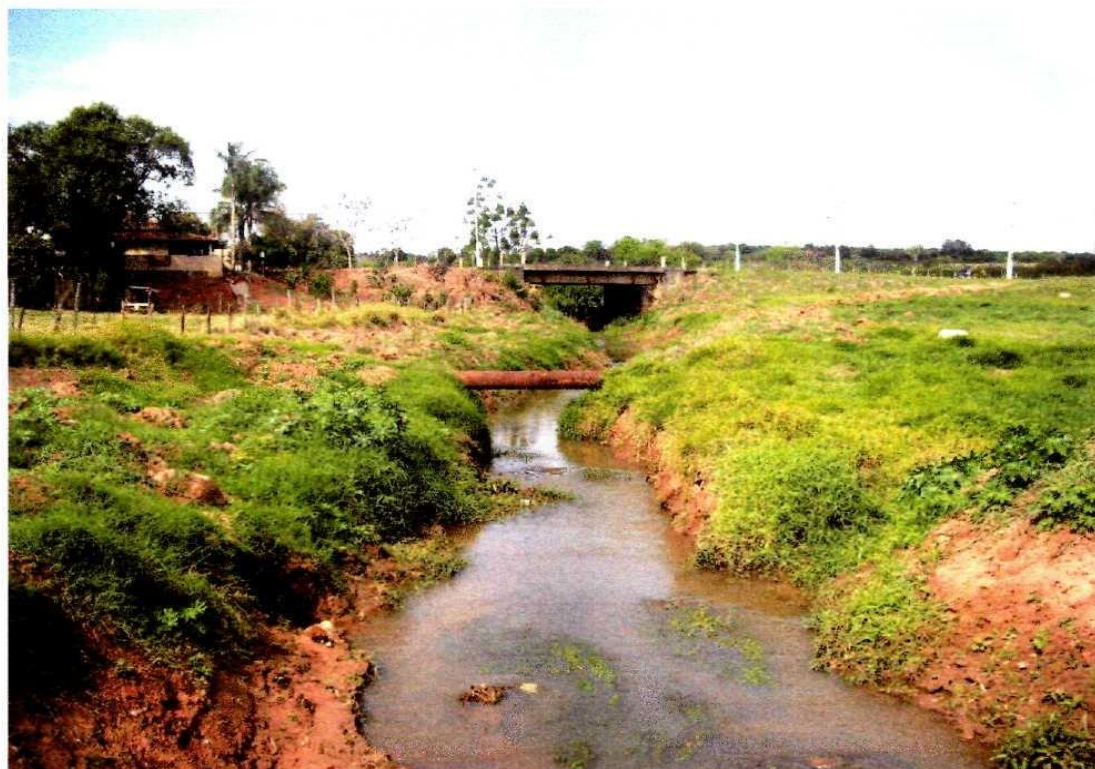
Foto. 4 – Mostra o Córrego Barreiro, a ponte de concreto da Rua Pedro de Toledo e a tubulação de coleta de esgoto.
