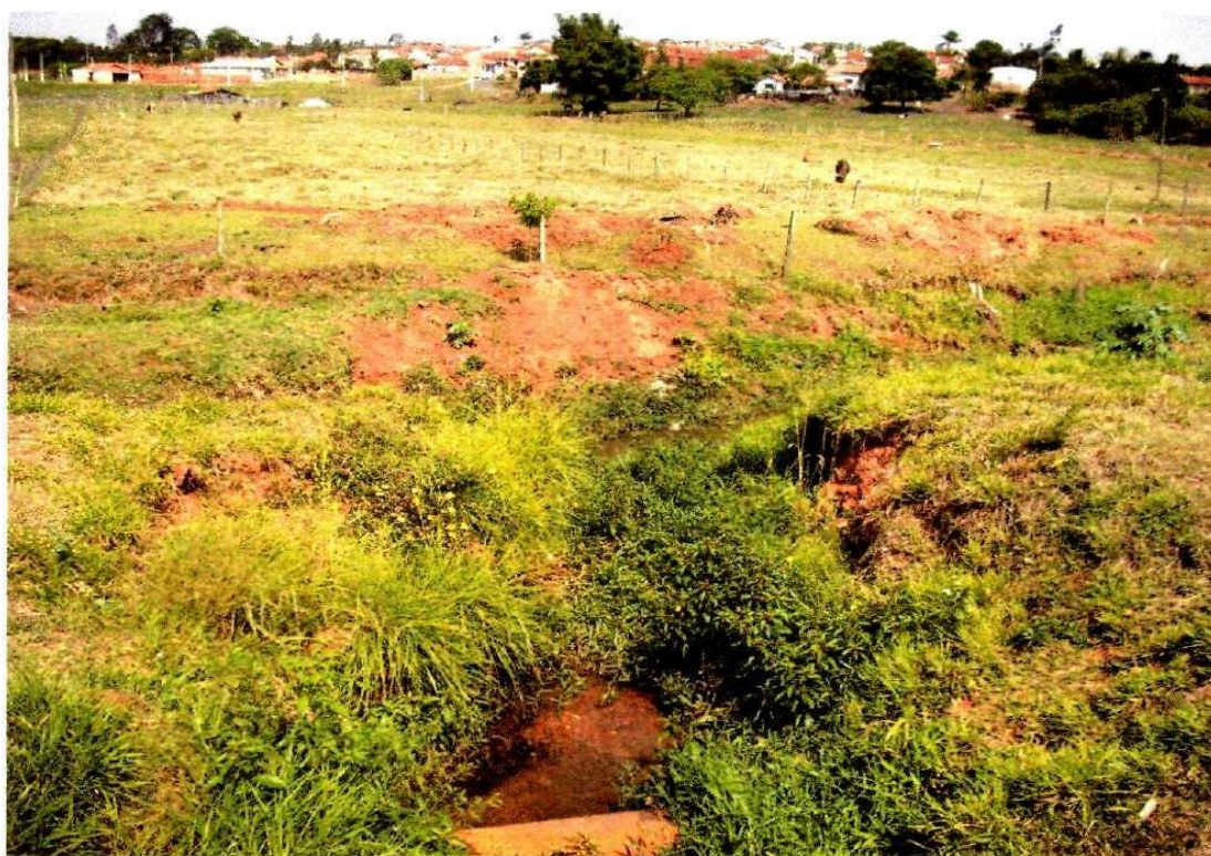
Foto. 3 – Mostra a foz do Córrego Cisterna, afluente do Córrego Monjo-linho.
