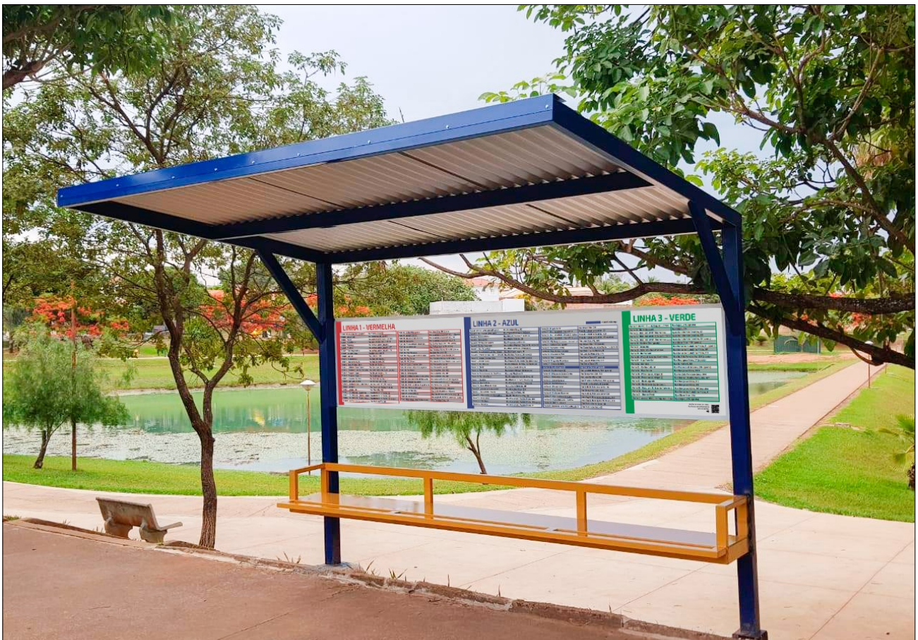
Alguns dos pontos de ônibus para embarque e desembarque dos circulares já possuem itinerário com os pontos de parada. Foto: Carina Costa / Prefeitura de Urupês
