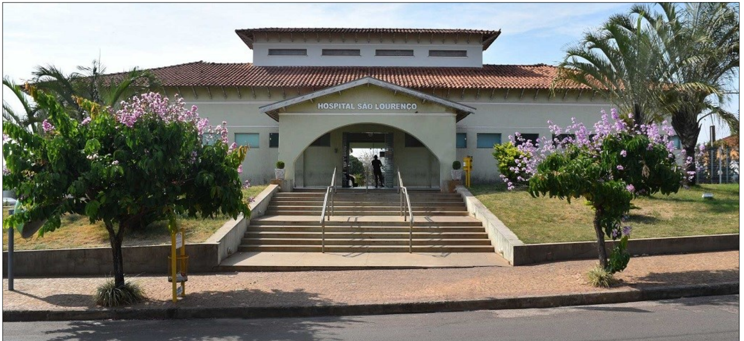
Pronto Socorro Municipal fica localizado no prédio do Hospital São Lourenço. Foto: Luís Fernando da Silva / Prefeitura Municipal de Urupês.
