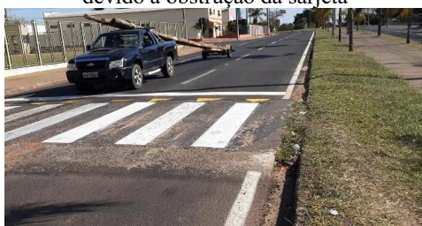
Figura 4.4.101 – Av Labieno da Costa Machado, entre a R Alvinho de Oliveira e a R Valter Alves de Souza, onde a água não escoa devido à obstrução da sarjeta
