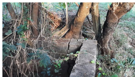
Figura 4.4.157 – Rachadura na estrutura da caixa de drenagem na margem direita da nascente do Ribeirão Tibiriçá
