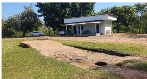
Figura 4.2.14 – Plataforma para descarregamento de esgoto, localizada antes do pré-tratamento da ETE Peixe
