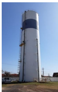
Figura 4.1.43 – Reservatório de concreto Rebelo, de 1.000 m³
