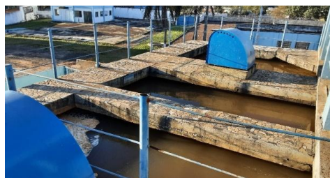
Figura 4.1.30 – Floculadores mecânicos da ETA Garça
