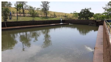
Figura 4.1.12 – Canaleta que esco a água coletada pelos drenos para o tanque de concreto da ECR B2
