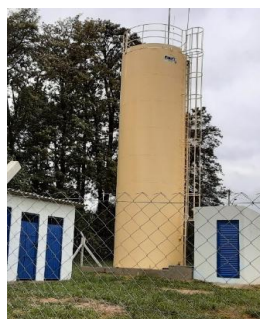
Figura 4.1.50 – Reservatório metálico Campo Belo, de 70 m 3
