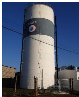
Figura 4.1.48 – Reservatório metálico Le Sorelle, de 60 m 3
