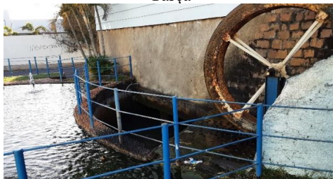
Figura 4.1.33 – Tanque em que a água da lavagem dos filtros e decantadores é armazenada até ser recirculada para a ETA Garça
