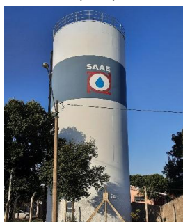
Figura 4.1.49 – Reservatório metálico Ecoville, de 200 m 3
