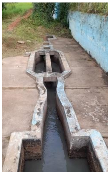
Figura 4.2.33 – Caixa de areia e calha parshall da ETE Jafa
