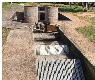
Figura 4.2.5 – Calha parshall da ETE Peixe
