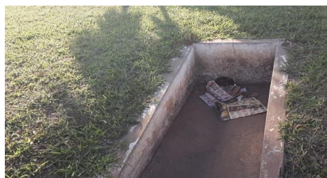
Figura 4.4.107 – Tubulação de captação de água pluvial na rotatória da Av Labieno da Costa Machado, esquina com a Av da Saudade, onde ocorrem alagamentos durante precipitações intensas
