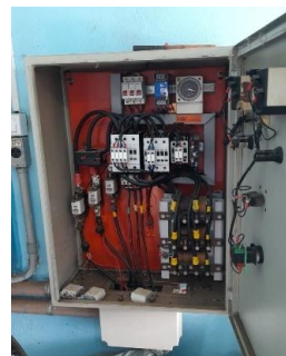
Figura 4.2.37 – Painéis elétricos dos aeradores da ETE Jafa
