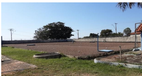
Figura 4.1.39 – Reservatório de concreto enterrado ETA 01, de 4.800 m 3
