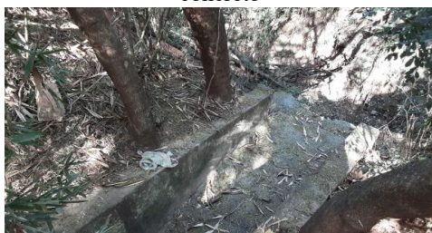
Figura 4.4.137 – Erosão ao lado do dispositivo de drenagem na R Antonio Ribeiro da Silva, comprometendo a estabilidade da canaleta
