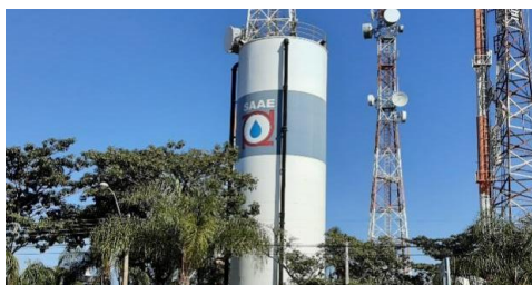
Figura 4.1.46 – Reservatório metálico Vila Araceli (CREA), de 1.000 m 3
