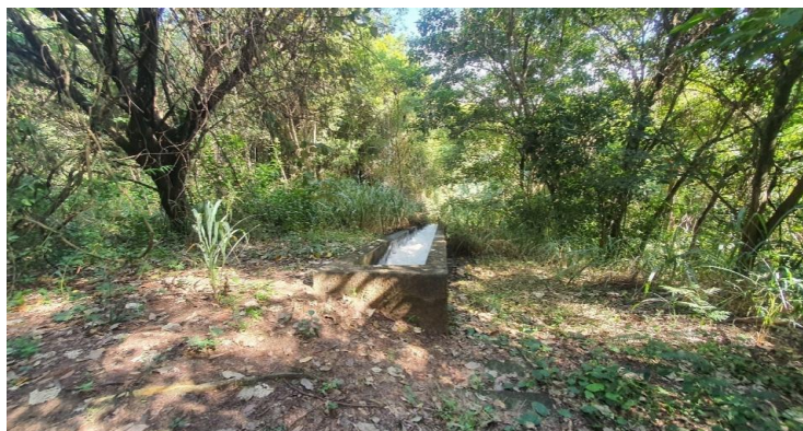
Figura 4.2.30 – Escada de aeração da ETE Tibiriçá
