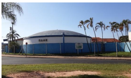
Figura 4.1.45 – Reservatório enterrado de concreto Adrianita, de 80 m 3
