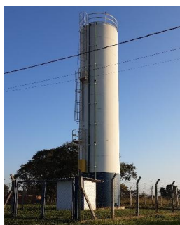
Figura 4.1.51 – Reservatório metálico Europa, de 120 m 3
