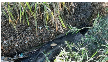
Figura 4.4.171 – Dissipador de drenagem em gabião na tubulação de drenagem superficial do Jd. Morada do Sol
