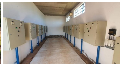
Figura 4.2.15 – Painéis elétricos dos aeradores da ETE Peixe
