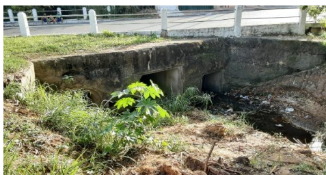
Figura 4.4.130 – Erosão em curso ao lado do dispositivo de drenagem ao fim da R Francisco da Silva Braga, comprometendo a estabilidade da alvenaria
