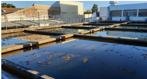
Figura 4.1.31 – Decantadores da ETA Garça
