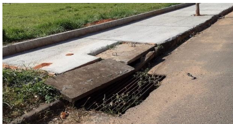
Figura 4.4.101 – Av Labieno da Costa Machado, entre a R Alvinho de Oliveira e a R Valter Alves de Souza, onde a água não escoa devido à obstrução da sarjeta
