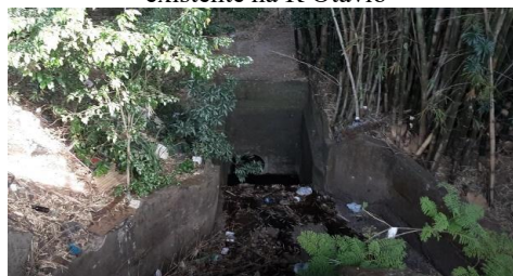
Figura 4.4.123 – Fundo degradado do dispositivo de drenagem existente na R Gabriela
