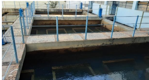
Figura 4.1.32 – Filtros da ETA Garça
