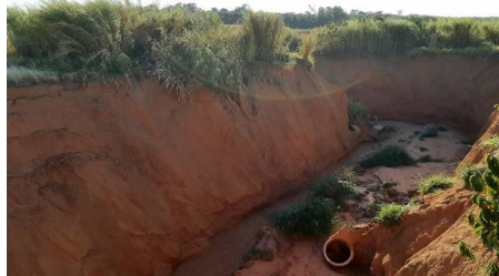
Figura 4.4.190 – Erosão na drenagem do bairro Residencial do Bosque
