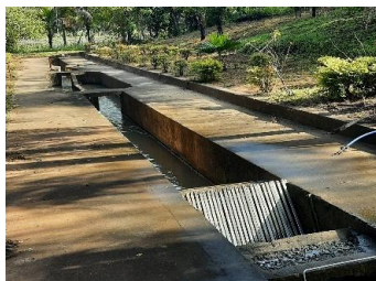
Figura 4.2.20 – Calha parshall da ETE Tibiriçá
