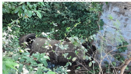
Figura 4.4.141 – Dissipador de drenagem na R Luiz Valsecchi. O corpo hídrico é canalizado da R Rosário Martino até este ponto, em que passa a escoar superficialmente
