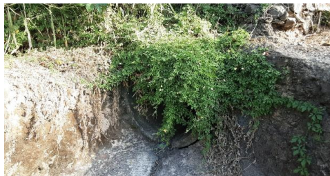
Figura 4.4.178 – Tubo remanescente da drenagem do Jd. Zapata, que foi deslocado por meio de processos erosivos
