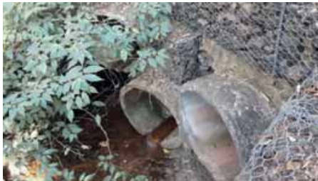
Figura 4.4.186 – Dissipador do Jd. São Benedito, entregue em 2021, com falhas em sua estrutura
