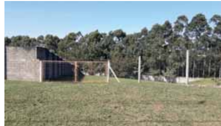
Figura 4.4.206 – Bacia de detenção do Jd. Vista Verde
