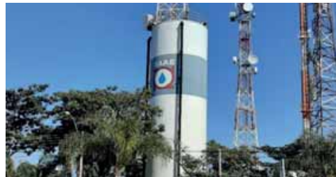
Figura 4.1.46 – Reservatório metálico Vila Araceli (CREA), de 1.000 m 3
