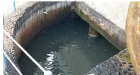
Figura 4.1.34 – Tanque em que a água da lavagem dos filtros e decantadores é armazenada até ser recirculada para a ETA Garça
