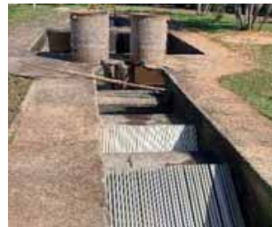
Figura 4.2.5 – Calha parshall da ETE Peixe
