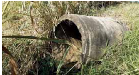
Figura 4.4.174 – Tubulação de drenagem superficial do Jd. Morada do Sol, adjacente à EP de esgoto Morada do Sol
