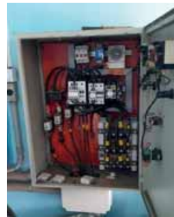
Figura 4.2.36 – Painéis elétricos dos aeradores da ETE Jafa
