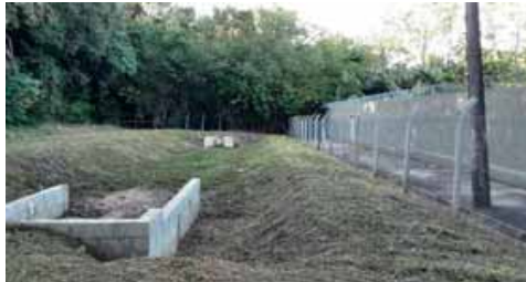
Figura 4.4.205 – Bacia de detenção do Residencial Gran Villagio
