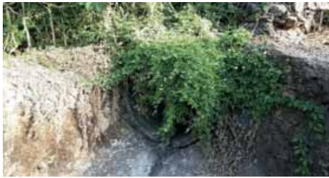
Figura 4.4.178 – Tubo remanescente da drenagem do Jd. Zapata, que foi deslocado por meio de processos erosivos
