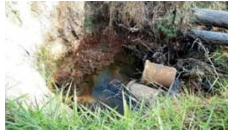
Figura 4.4.167 – Dispositivo de drenagem loteamento Jd. Monte Verde, com falhas na estrutura
