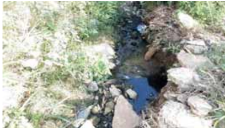
Figura 4.4.134 – Local onde havia a canaleta de drenagem degradada na esquina da R Tupy com a R São Paulo, que conduz a água até o corpo hídrico
