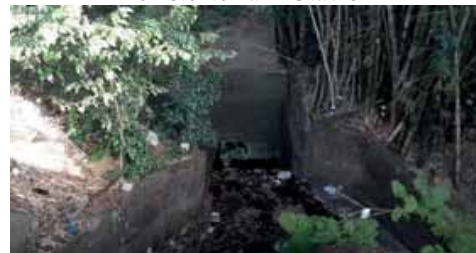
Figura 4.4.123 – Fundo degradado do dispositivo de drenagem existente na R Gabriela
