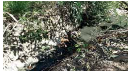
Figura 4.4.129 – Corpo hídrico após o dispositivo de drenagem na travessia na R Sete de Setembro
