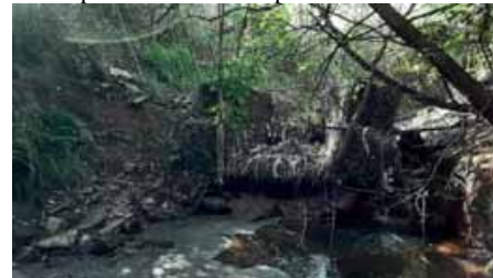
Figura 4.4.143 – Erosão causada pela drenagem superficial em dispositivo sem dissipador, na R Aparecido Martins, adjacente à EEE Nova Garça
