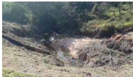
Figura 4.4.15 – Córrego Distrito Industrial 2 antes da travessia da Rodovia Comandante João Ribeiro de Barros
