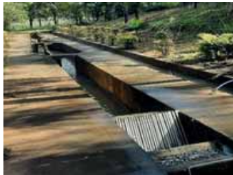
Figura 4.2.20 – Calha parshall da ETE Tibiriçá
