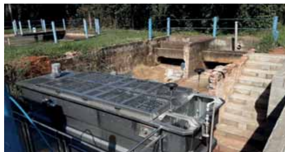
Figura 4.2.38 – Reforma em andamento na ETE Jafa
