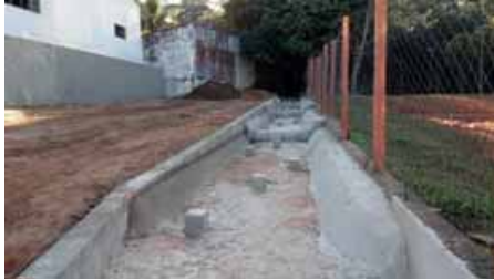
Figura 4.4.184 – Dissipador de drenagem na R Ataliba Leonel. Tubulações à esquerda e à direita são de redes de drenagem superficial, e a central coleta água do lago e de minas que foram canalizadas
