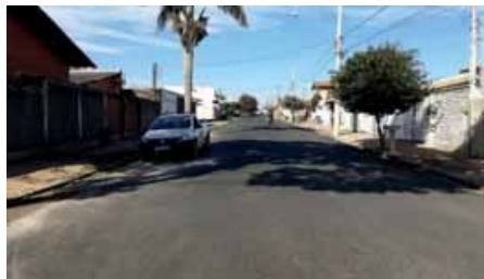
Figura 4.4.84 – R João Bento, esquina com a R Mario Marangão, onde ocorrem empoçamentos
