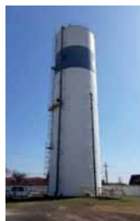
Figura 4.1.43 – Reservatório de concreto Rebello, de 1.000 m 3
