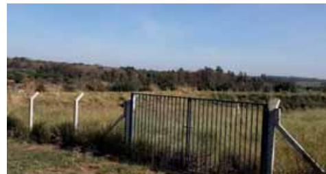
Figura 4.4.194 – Dispositivo da bacia de detenção do Jd. Le Sorelle
