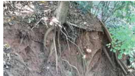
Figura 4.4.127 – Água acumulada adjacente ao dissipador de drenagem em gabião na R Sete de Setembro
