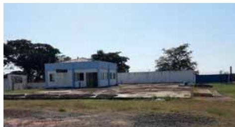
Figura 4.1.40 – Reservatório de concreto enterrado ETA 02, de 2.400 m 3
