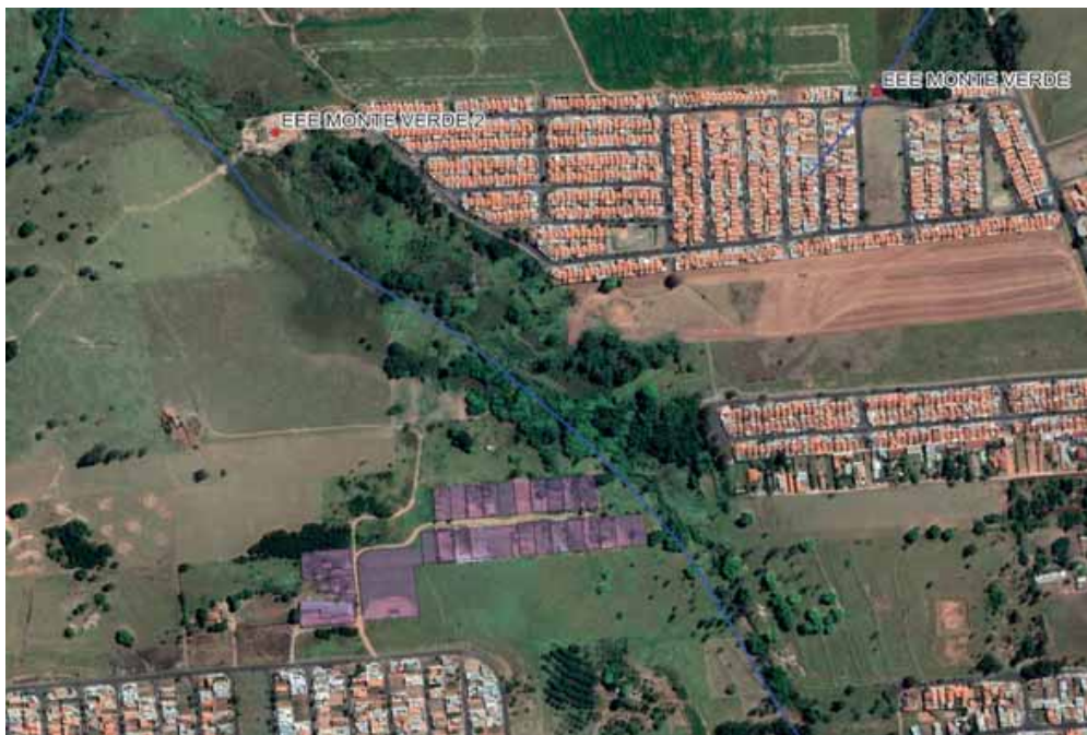
de esgoto, denominada “Portal do Sol”
