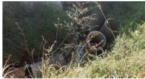
Figura 4.4.145 – Dispositivo de drenagem deslocado da rede de drenagem do bairro Nova Garça, próximo à esquina da Av Perimetral com a R Luiz Valsecchi
