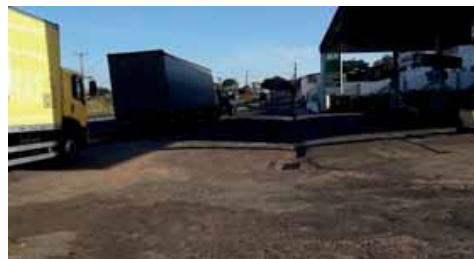
Figura 4.4.48 – Av Presidente Vargas, em frente ao posto Angélica, onde ocorrem alagamentos durante precipitações intensas
