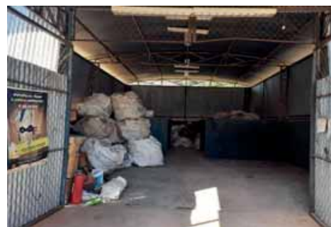
Figura 4.5.28 – Armazenamento dos resíduos
