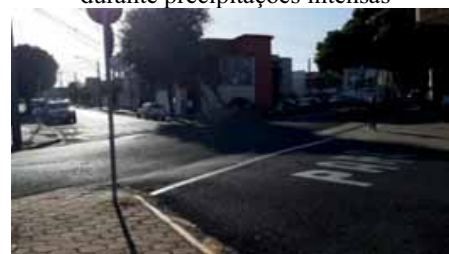
Figura 4.4.81 – Erosão lateral na Av. Victor Hugo Boareto, próximo à Av. Vereador Olivio Turato
