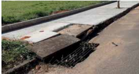
Figura 4.4.101 – Av Labieno da Costa Machado, entre a R Alvino de Oliveira e a R Valter Alves de Souza, onde a água não escoou devido à obstrução da sarjeta
