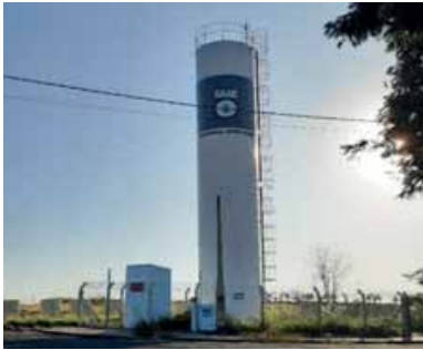
Figura 4.1.53 – Reservatório metálico Vista Verde 1 em Jafa, de 50 m3
