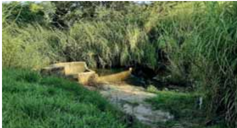
Figura 4.1.17 – Barramento de concreto da Captação Tibiriçá
