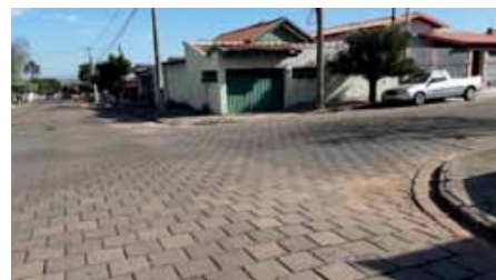
Figura 4.4.87 – R Sargento Wilson Abel de Oliveira, esquina com a R José Lourenço, onde ocorrem empoçamentos
