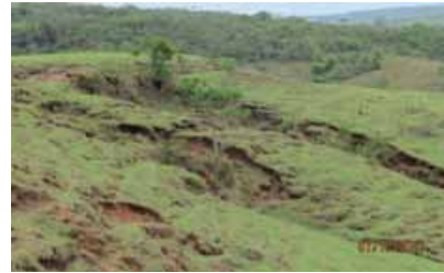
Figura 4.4.221 – Processos erosivos (sulcos e ravinas) desencadeados em meia encosta na bacia hidrográfica do Córrego da Cascata
