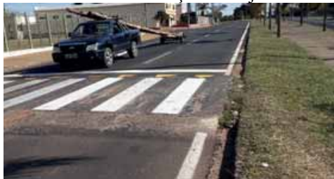
Figura 4.4.101 – Av Labieno da Costa Machado, entre a R Alvino de Oliveira e a R Valter Alves de Souza, onde a água não escoou devido à obstrução da sarjeta
