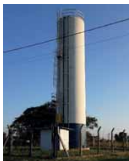
Figura 4.1.51 – Reservatório metálico Europa, de 120 m 3
