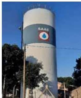
Figura 4.1.49 – Reservatório metálico Ecoville, de 200 m 3
