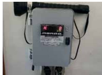
Figura 4.2.7 – Medidor ultrassônico que registra a vazão afluyente à ETE Peixe
