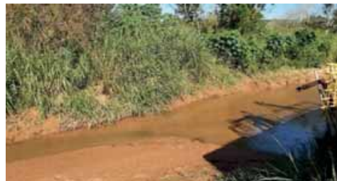
Figura 4.1.4 – Situação atual da barragem do Córrego da Cascata
