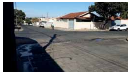
Figura 4.4.89 – R Jose Vizotto, esquina com a R Albano Vizotto, onde ocorrem empoçamentos
