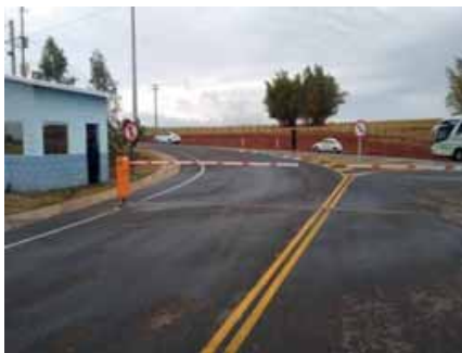
Figura 4.5.15 – Unidade de Valorização Sustentável (Aterro Sanitário)
