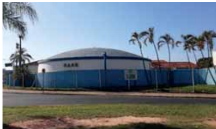
Figura 4.1.45 – Reservatório enterrado de concreto Adrianita, de 80 m 3
