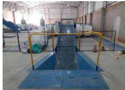
Figura 4.5.20 – Disposição dos rejeitos
