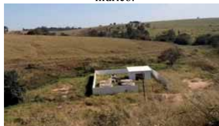
Figura 4.4.32 – EEE Monte Verde 2, adjacente ao Córrego Parque Real. Há uma rede de chegada do efluente na EEE sobre o corpo hídrico.
