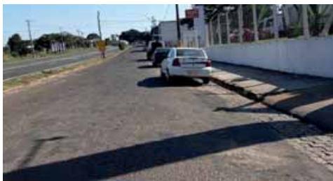
Figura 4.4.47 – Vista da Av Presidente Vargas, entre a R Santo Antônio e R Santa Eulália, onde a água escoava em velocidade elevada durante precipitações intensas
