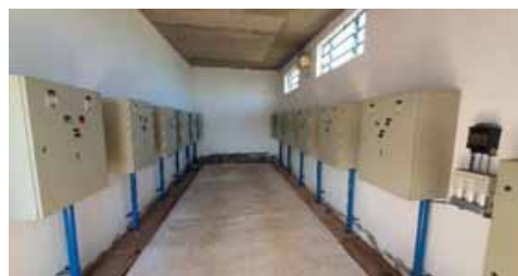
Figura 4.2.15 – Painéis elétricos dos aeradores da ETE Peixe
