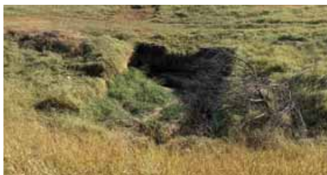
Figura 4.4.152 – Caixa de drenagem adjacente à linha férrea e próximo ao cemitério, que recebe o que é captado em tubulações de drenagem no Distrito Industrial 2
