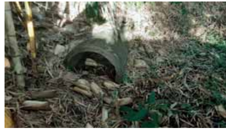
Figura 4.4.179 – Erosão onde havia rede de drenagem do Jd. Zapata
