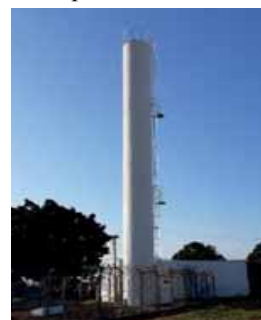
Figura 4.1.52 – Reservatório metálico ETA Jafa 02, de 100 m 3 , e reservatório de concreto ETA Jafa 01, de 80 m 3
