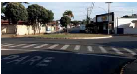
Figura 4.4.114 – R Dona Maria de Barros, esquina com a R Fausto Floriano, onde há empoçamento durante precipitações intensas
