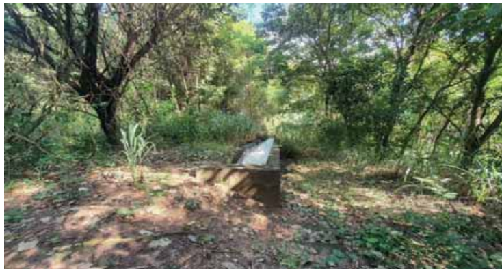
Figura 4.2.30 – Escada de aeração da ETE Tibiriçá
