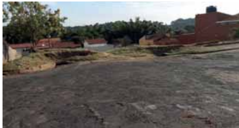
Figura 4.4.112 – Av Paineiras, esquina com R Imbuia, onde ocorrem empoçamentos durante precipitações intensas
