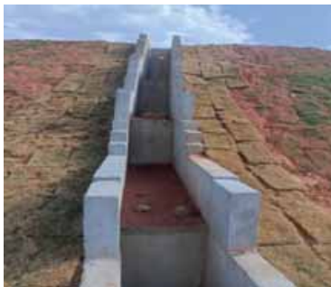
Figura 4.5.40 – Escada hidráulica para amortizar a velocidade da chuva
