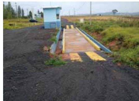
Figura 4.5.16 – Carreta do município de Garça descarregando no aterro
