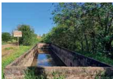
Figura 4.2.14 – Plataforma para descarregamento de esgoto, localizada antes do pré-tratamento da ETE Peixe
