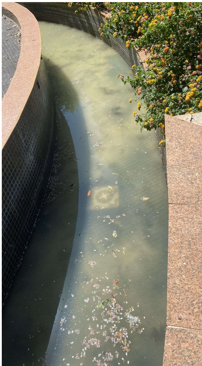
Foto 1. Água acumulada na fonte da Praça 9 de Julho
