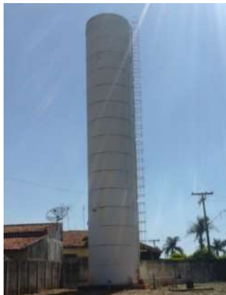
Figura 12 – Vista do reservatório RA 4.
