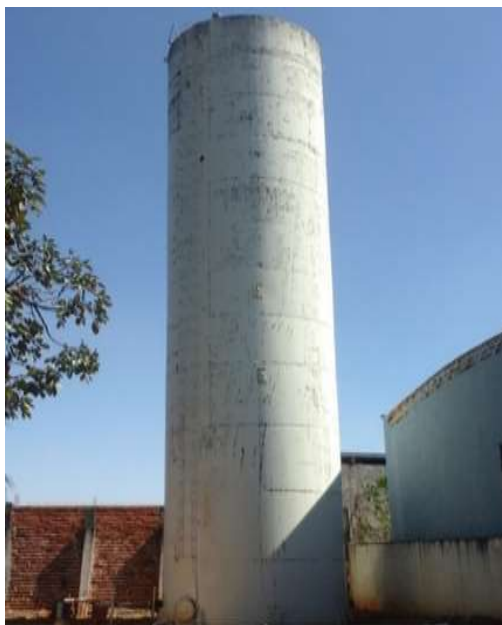
Figura 20 – Aspectos do reservatório RA 8 .
