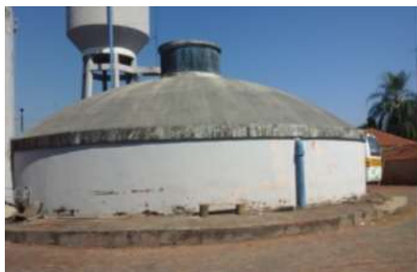
Figura 9 – Vista do reservatório apoiado RA-3.
