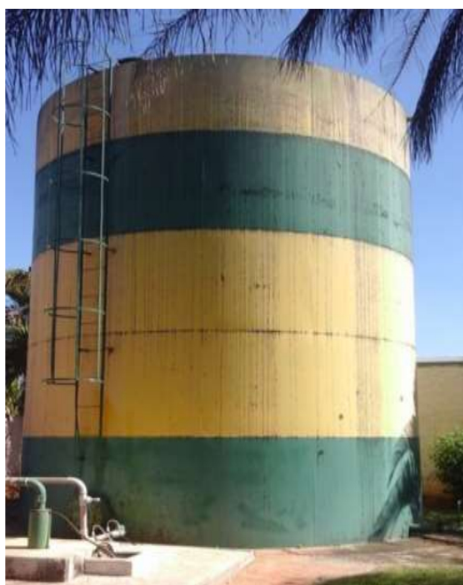
Figura 16 – Aspectos do reservatório RA 6.
