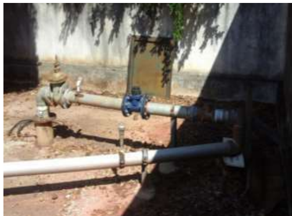
Figura 8 – Aspectos do poço P 3.
