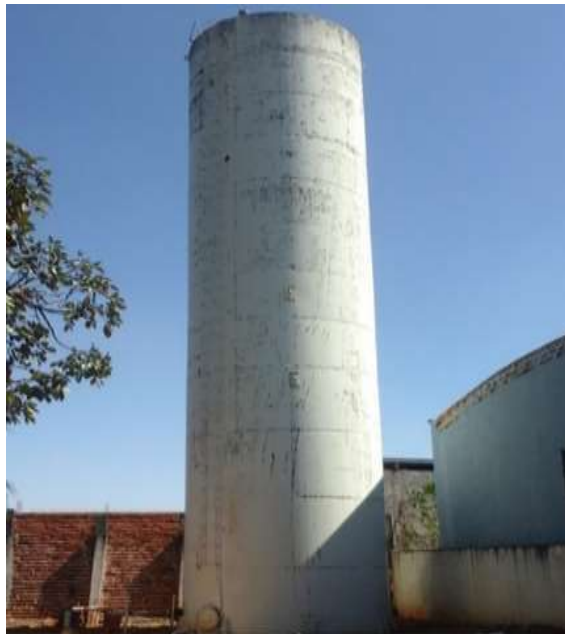
Figura 18 – Aspectos do reservatório RA 7.
