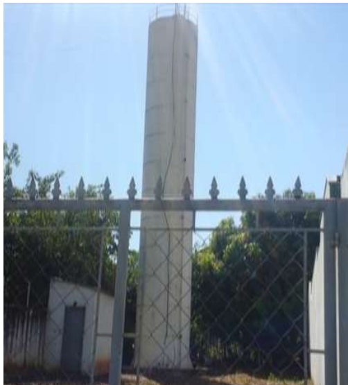
Figura 26 – Aspectos do reservatório RA 11.
