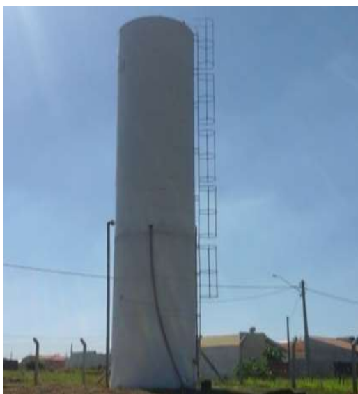
Figura 29 – Aspectos do reservatório RA 12 .
