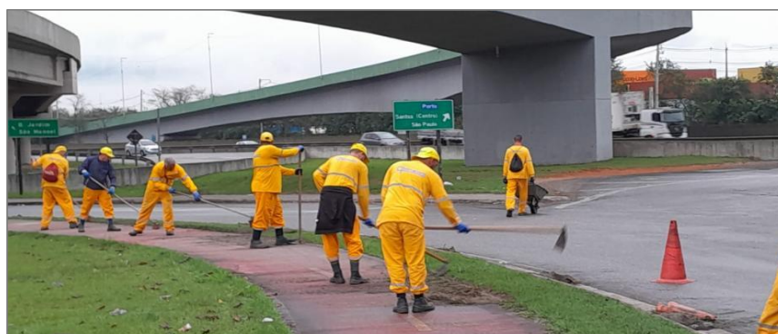
Figura 56. Exemplo de prática de capina e raspagem executada por prefeitura com a utilização de EPIs
