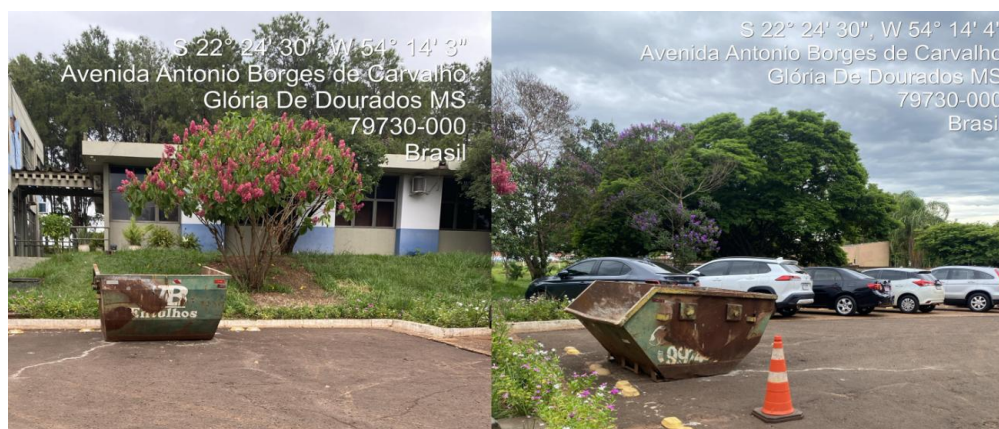
Figura 29. resíduos de construção civil de Glória de Dourados/MS
