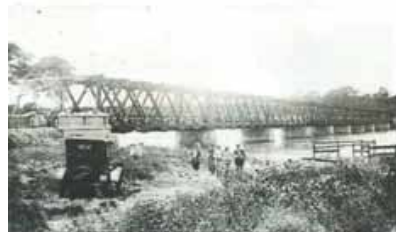
PONTE ANTIGA, INAUGURADA EM 1928 E INTERDITADA EM 1929
