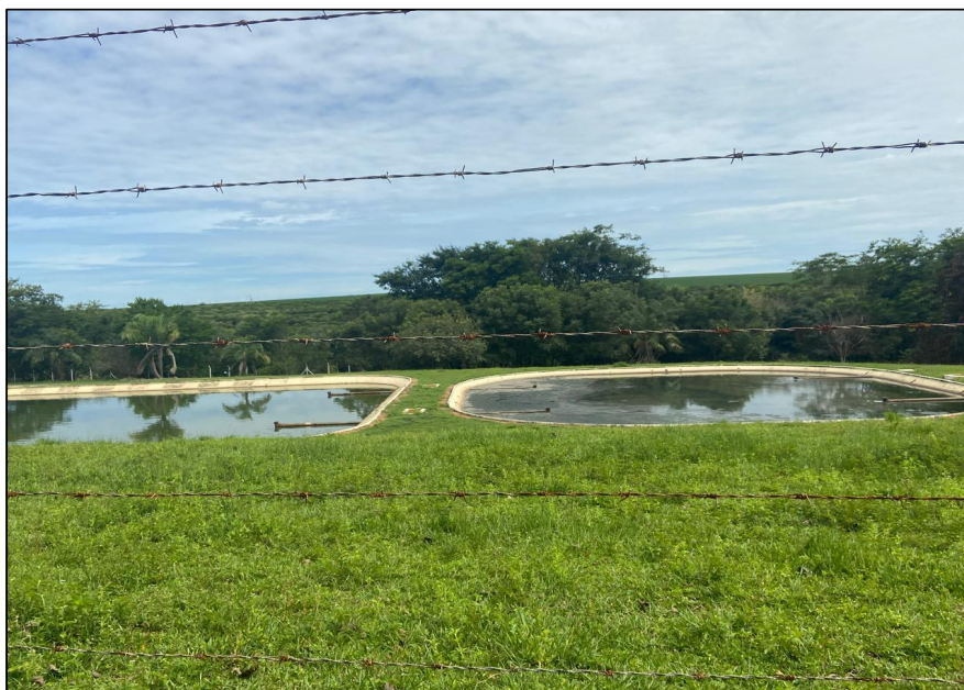
Figura 38 – Lagoas de Tratamento - Estação de Tratamento de Esgoto Vitória Brasil - Sabesp.
