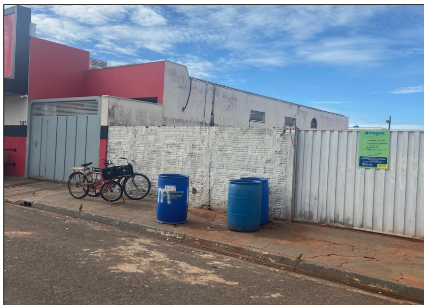
Figura 21 – Dispositivos de armazenamento de resíduos - tambores.
