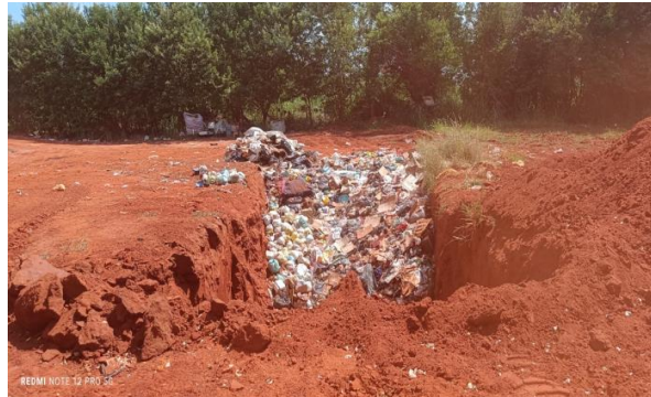
Figura 2 – Vista parcial do aterro sanitário em valas.
