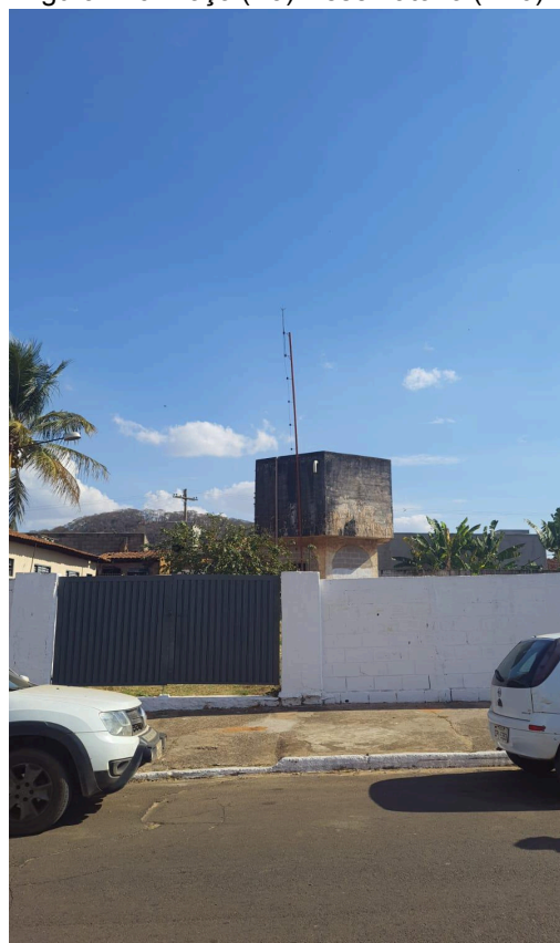
Figura 116: Poço (P9) Reservatório (R10).
