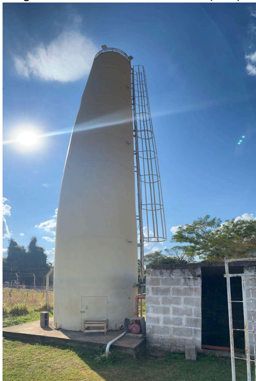
Figura 131: Reservatório elevado (R13).
