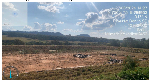
Figura 152: Lagoa de tratamento.
