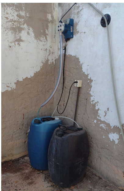
Figura 67: Casa de cloração e fluoretação.
