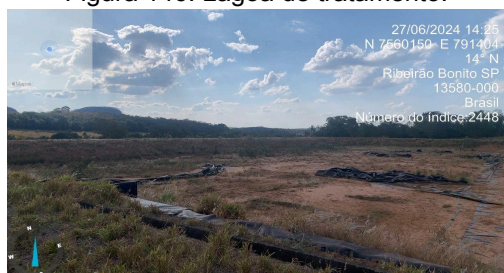
Figura 146: Lagoa de tratamento.
