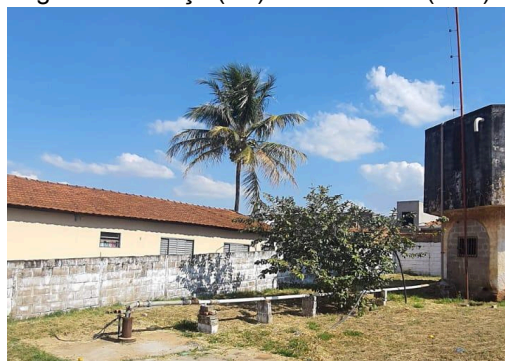
Figura 114: Poço (P9) Reservatório (R10).
