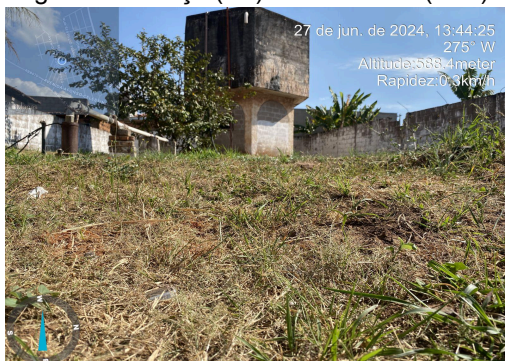
Figura 113: Poço (P9) Reservatório (R10).
