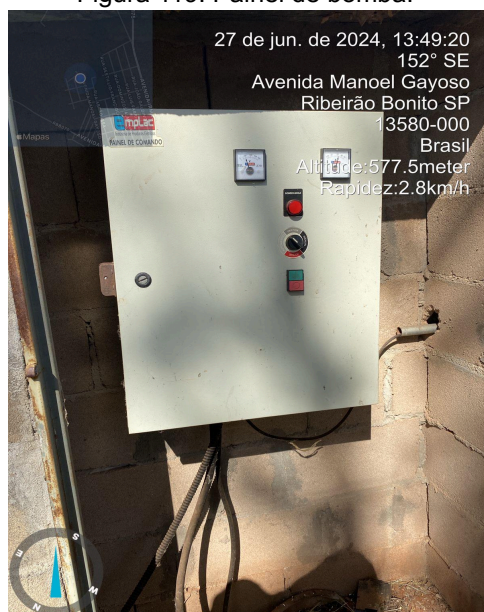
Figura 119: Painel de bomba.
