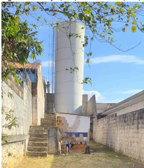
Figura 127: Poço (P11) Reservatório (R12).
