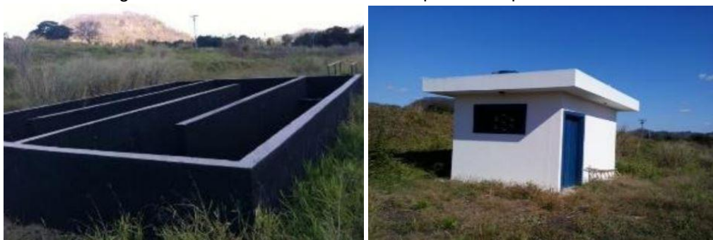
Figura 180 e 181. Chicanas e casa de química respectivamente
