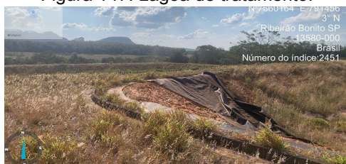
Figura 147: Lagoa de tratamento.
