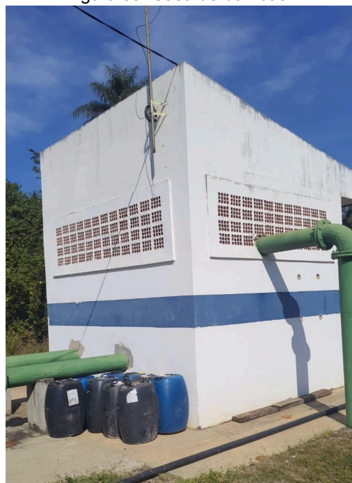
Figura 89: Casa de bombas.
