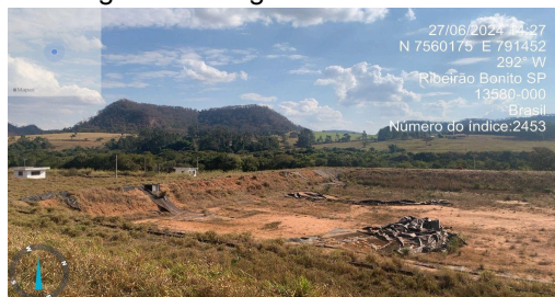
Figura 151: Lagoa de tratamento.
