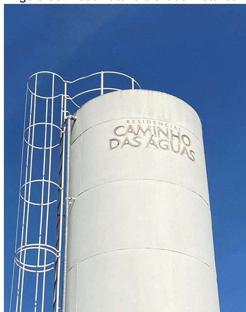
Figura 96: Reservatório elevado metálico.
