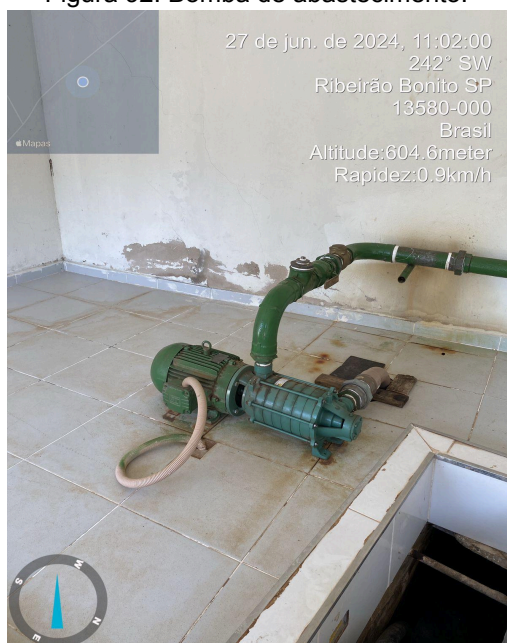
Figura 92: Bomba de abastecimento.
