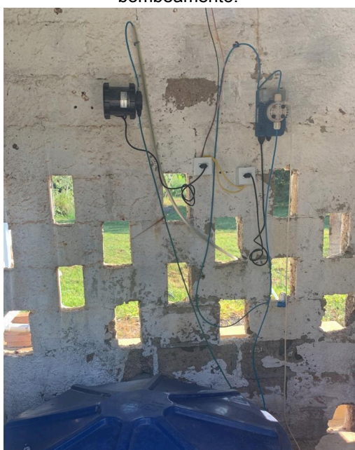
Figura 58: Casa de controle e bombeamento.
