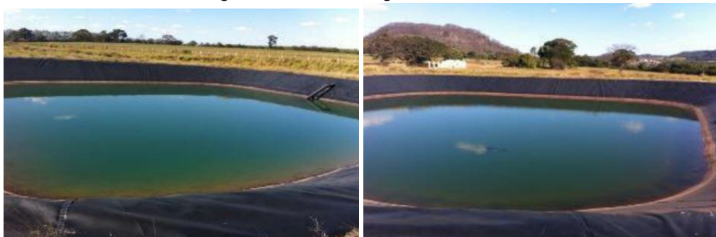
Figuras 176 e 177: Lagoas anaeróbias.
