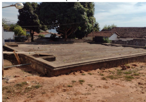
Figura 62: Reservatório semi-enterrado (R1).
