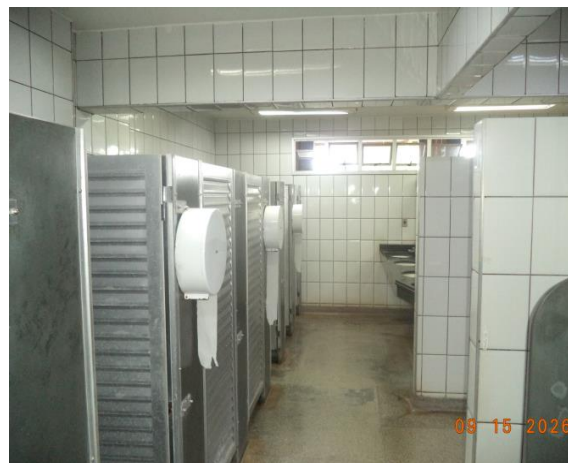
Banheiro grátis limpo
