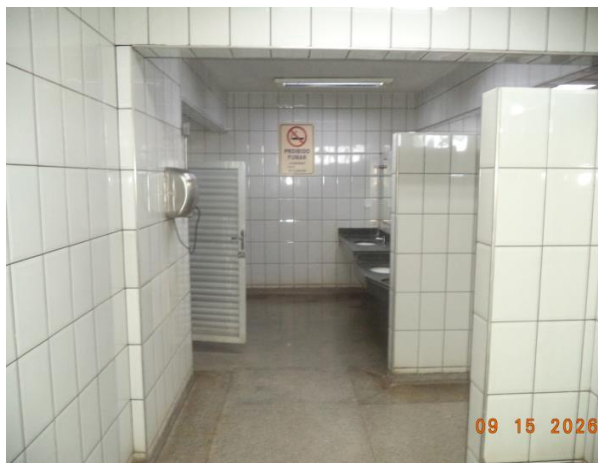
Banheiro grátis limpo
