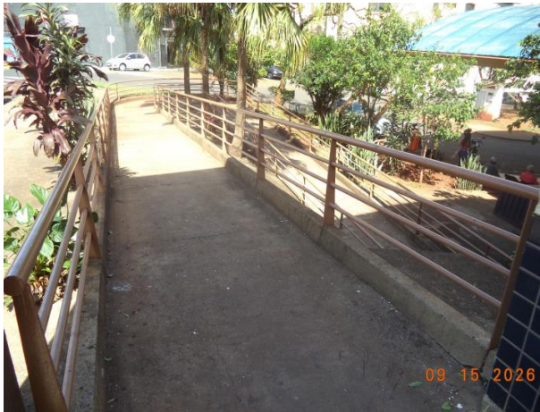
Rampa de acesso
