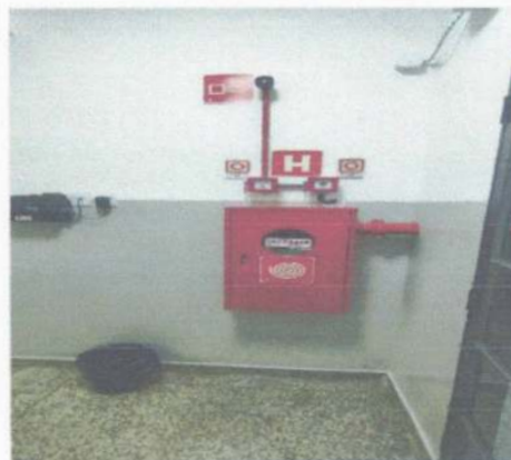
FIGURA 4 Equipamentos de Segurança
