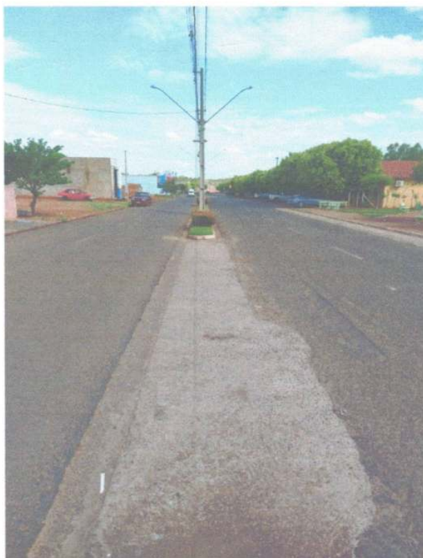
Foto 01 — Avenida Brasil, trecho de menor elevação do perímetro urbano
