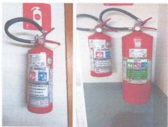
FIGURA 7 Equipamentos de Segurança
