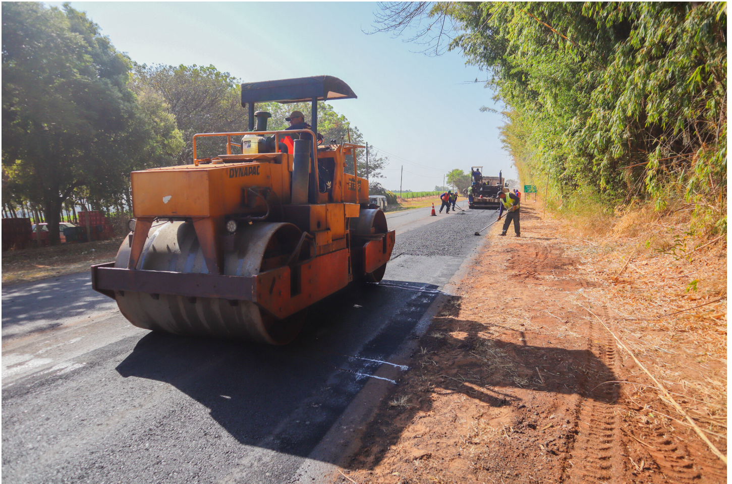
Rolo compressor trabalha para compactação do novo trecho recapeado. Foto: Henrique Alonso Camilo / Prefeitura Municipal de Urupês.
