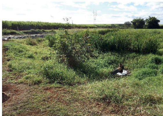
Foto 3.57 – Vista geral da lagoa facultativa totalmente eutrofizada
