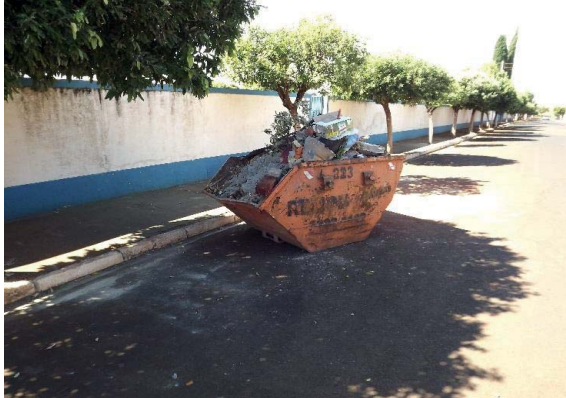
Foto 3.81 – Caçamba de acondicionamento de RCC
