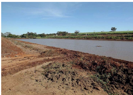
Foto 3.7 – Vista geral do reservatório no Córrego Viradouro
