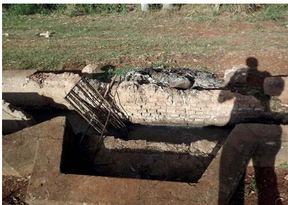
Foto 3.54 – Detalhe da estrutura de gradeamento parcialmente destruída
