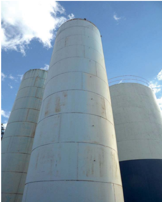
Foto 3.40 – RAP Nova Viradouro I
