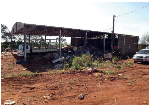
Foto 3.75 – Detalhe do barracão de coleta seletiva localizado no aterro sanitário.
