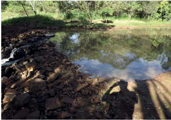
Foto 3.1 – Barragem (enrocamento) para captação de água superficial no Córrego do Sucuri
