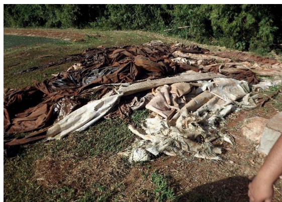
Foto 3.59 – Detalhe de bags utilizados para a retirada e secagem de lodo das lagoas
