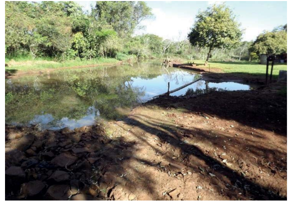
Foto 3.2 – Vista geral da barragem no Córrego do Sucuri
