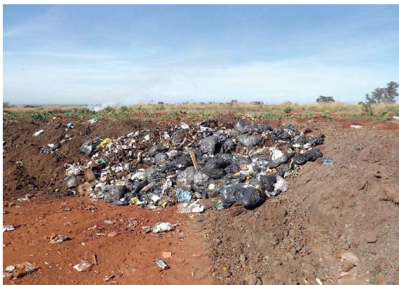
Foto 3.69 – Vista da frente de operação com a massa de resíduos recém-disposta
