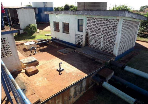
Foto 3.45 – Vista Geral do abrigo para os Conjuntos motobomba da EEAT I ETA
