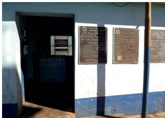
Foto 3.46 – Vista Geral da entrada do abrigo para os Conjuntos motobomba da EEAT I ETA
