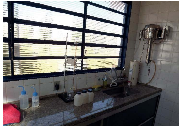
Foto 3.27 – Detalhe do laboratório para análises de água instalado na ETA
