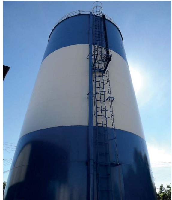
Foto 3.31 – RAP Julia em bom estado de conservação
