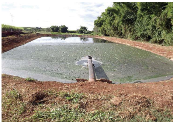
Foto 3.56 – Vista geral da lagoa anaeróbia com excesso de sobrenadante
