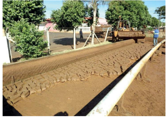
Foto 3.25 – Detalhe do leito de secagem de lodo com retirada
