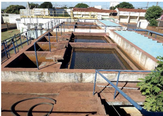
Foto 3.16 – Vista geral da ETA
