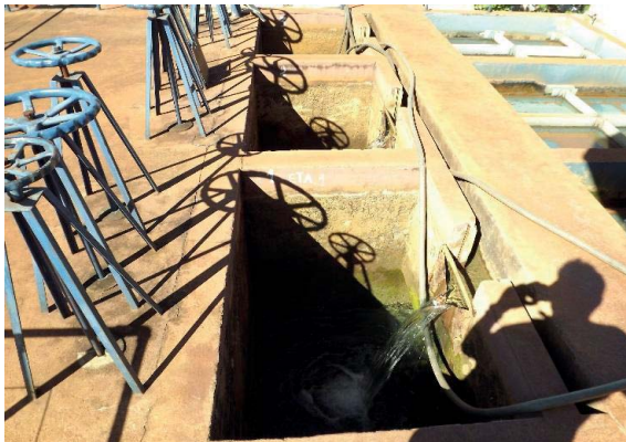
Foto 3.20 – Vista geral de uma das unidades de filtro rápido por gravidade
