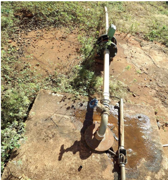
Foto 3.12 – Vista geral do Poço P2
