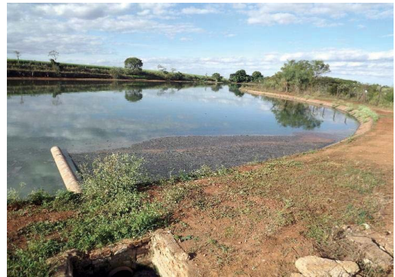
Foto 3.66 – Vista geral da lagoa facultativa
