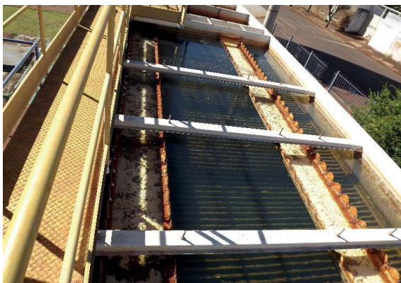
Foto 3.22 – Detalhe do decantador laminar ascendente de contato
