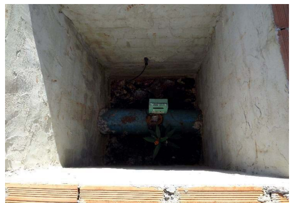
Foto 3.6 – Macromedidor instalado em uma das saídas da captação superficial
