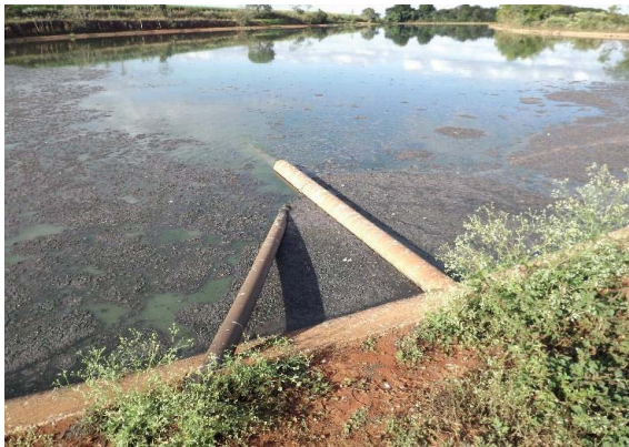
Foto 3.65 – Vista geral da lagoa facultativa com excesso de sobrenadante
