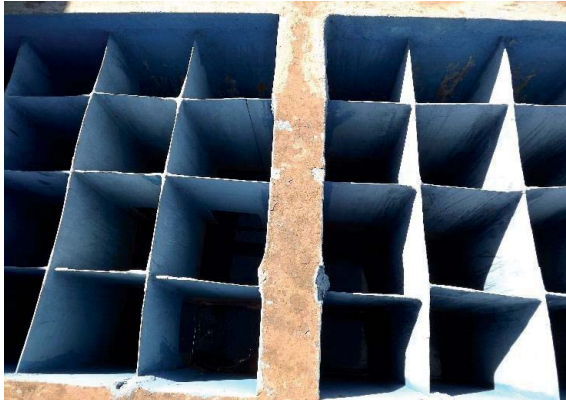
Foto 3.18 – Vista geral de flocculador hidráulico com chicanas de fibra de vidro
