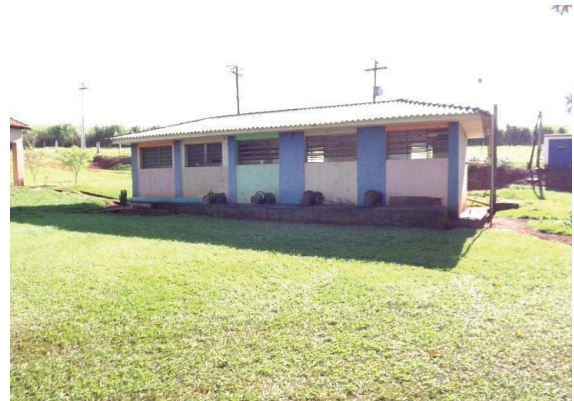
Foto 3.4 – Casa de bombas para recalque de água bruta
