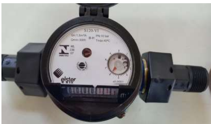
Figura 32 - Ligação domiciliar externa tipo cavalete – detalhe do hidrômetro
