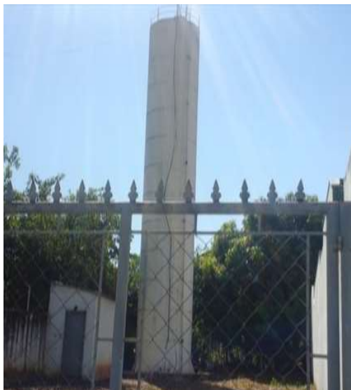
Figura 26 – Aspectos do reservatório RA 11.
