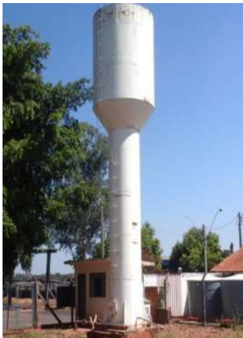
Figura 22 – Aspectos do reservatório RA 9.
