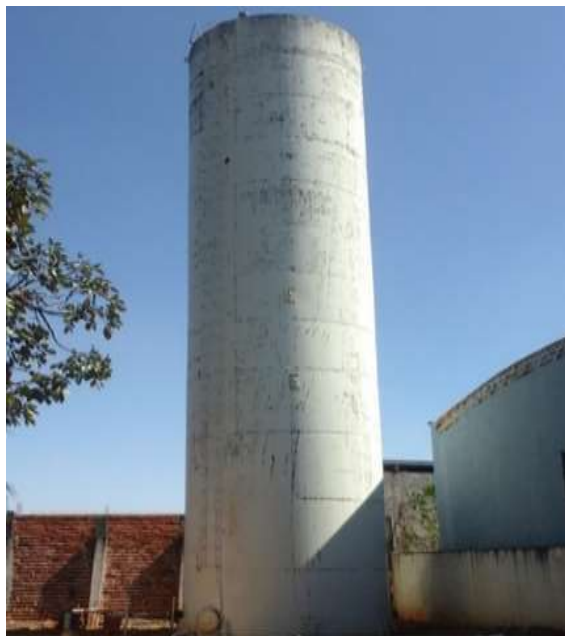
Figura 18 – Aspectos do reservatório RA 7.
