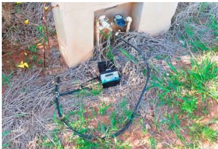
Figura 34 - Ligação domiciliar externa embutida em muro
