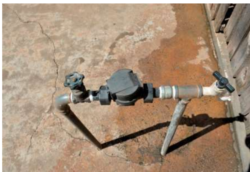
Figura 36 - Ligação domiciliar – Outro tipo de Padrão
