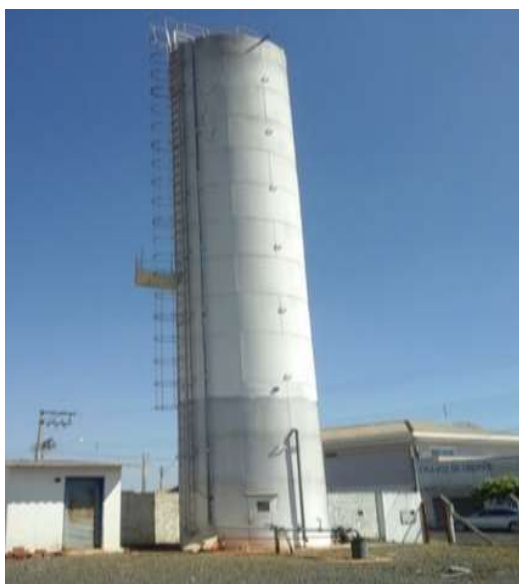
Figura 24 – Aspectos do reservatório RA 10.
