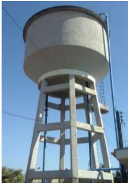
Figura 10 – Aspectos do reservatório elevado RA-3.
