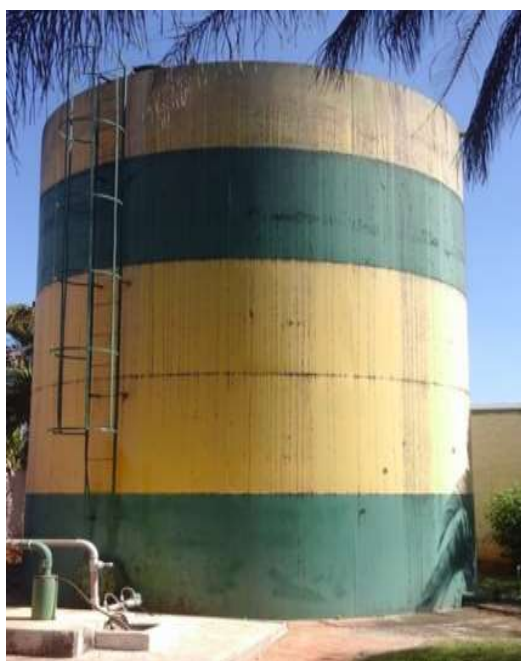
Figura 16 – Aspectos do reservatório RA 6.
