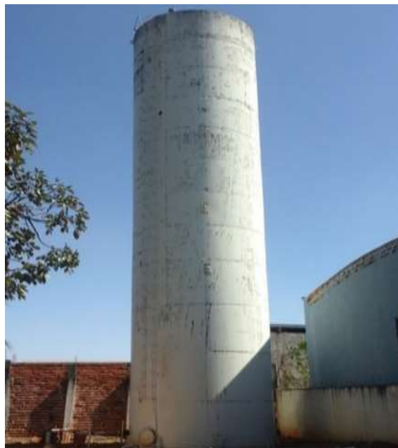
Figura 18 – Aspectos do reservatório RA 7.
