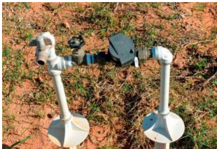
Figura 31 - Ligação domiciliar externa tipo cavalete
