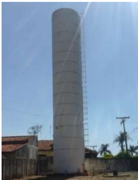
Figura 12 – Vista do reservatório RA 4.
