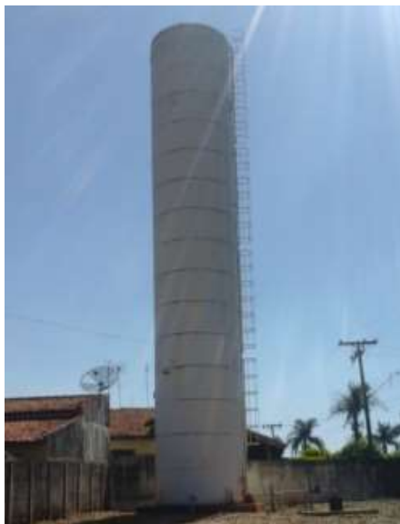
Figura 12 – Vista do reservatório RA 4.
