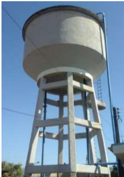
Figura 10 – Aspectos do reservatório elevado RA-3.
