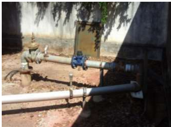
Figura 8 – Aspectos do poço P 3.
