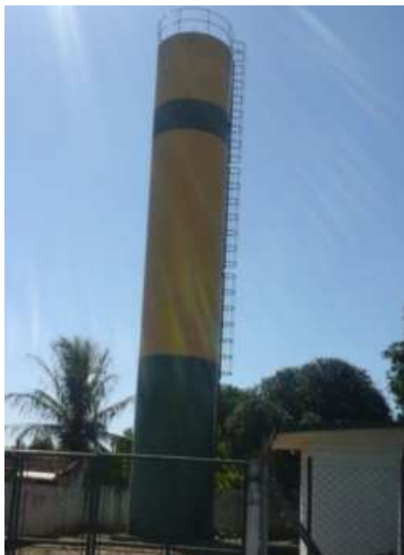
Figura 14 – Vista do reservatório RA 5.
