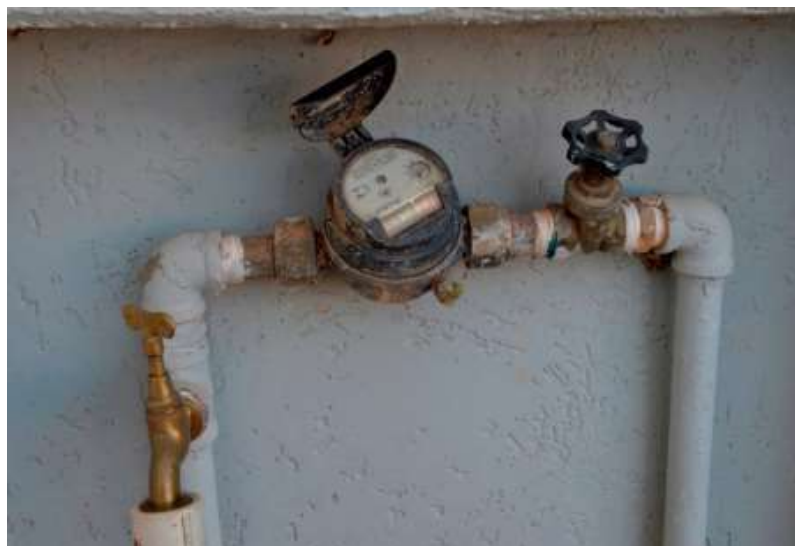
Figura 43 - Ligação domiciliar - padrão abrigado - medidor inclinado
