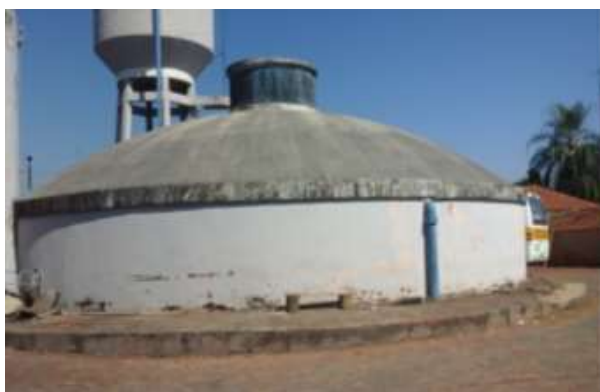
Figura 9 – Vista do reservatório apoiado RA-3.
