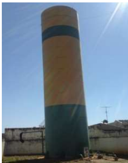
Figura 6 – Vista do reservatório RA 1.
