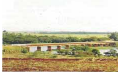
PONTE ATUAL, INAUGURADA EM 1937
