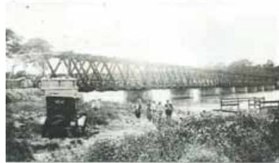
PONTE ANTIGA, INAUGURADA EM 1928 E INTERDITADA EM 1929
